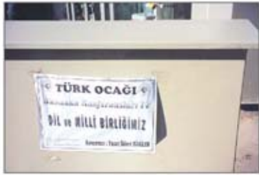
Telekom dağıtım kutuları ve elektrik direkleri en çok kirletilen kent mobilyaları arasında.
